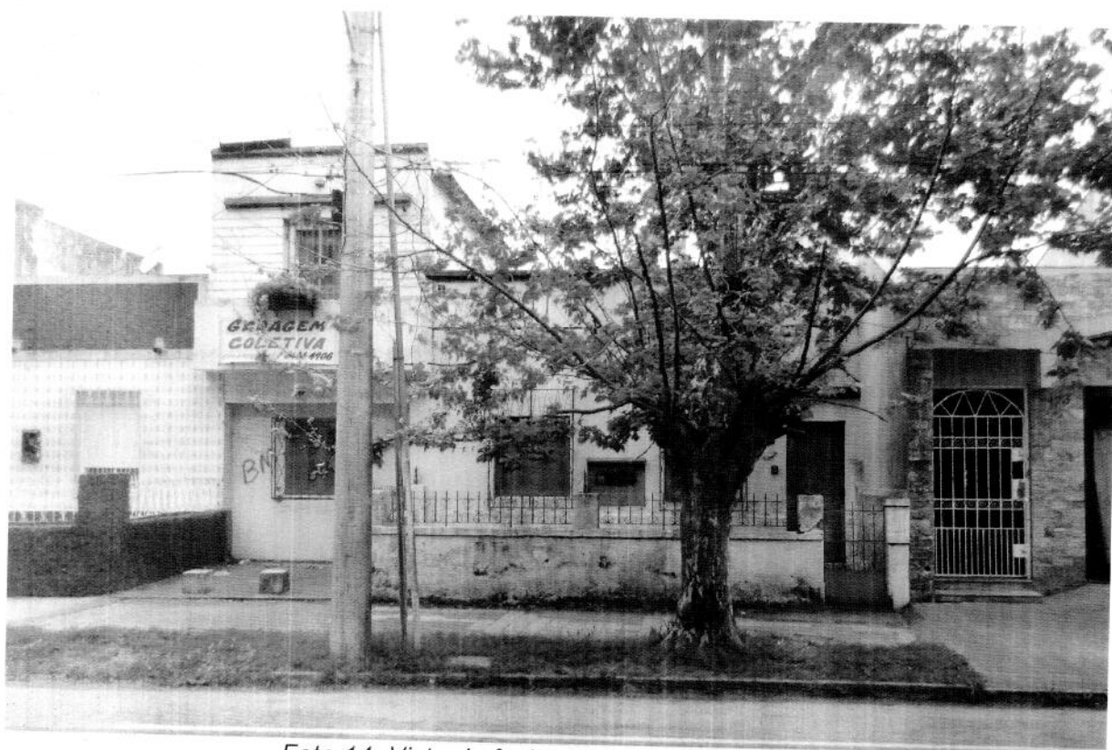
Foto 14: Vista da fachada na Av. Portugal 171
