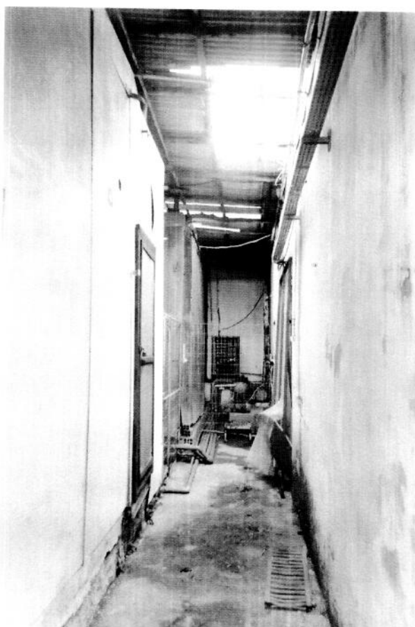
Foto 08: Vista Interna de circulação entre prédios
