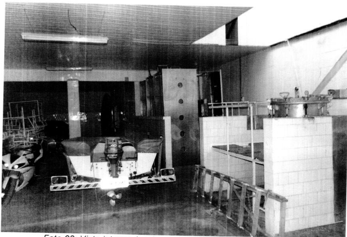
Foto 03: Vista interna, local onde funcionava setor de cozimento
