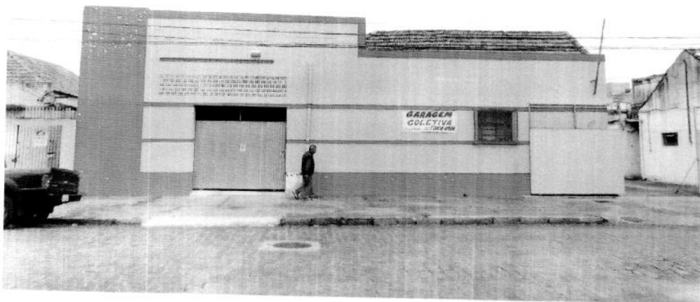
Foto 01: Vista da fachada a partir da Rua Caramuru
