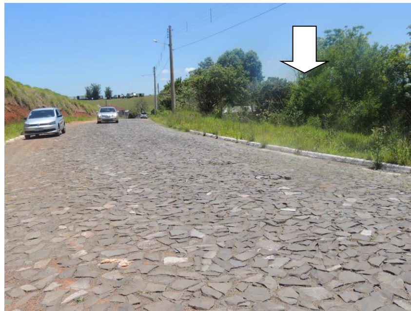
Vista parcial da testada da gleba para a Rua dos Gaúchos. Aspecto para a infraestrutura disponível
