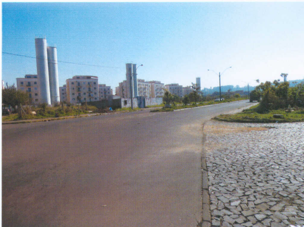
Vista de empreendimentos imobiliários residenciais localizados na Av. do Contorno, defronte ao imóvel avaliado
