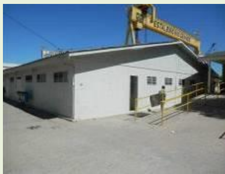
Vista do Vestiário 2
