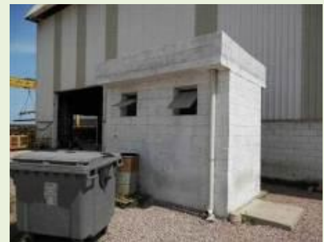
Vista do Sanitário do Galpão de Perfis
