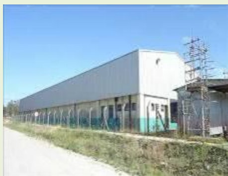
Vista do Armazém de Resíduos
