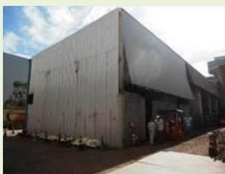
Vista do Galpão de Tubos
