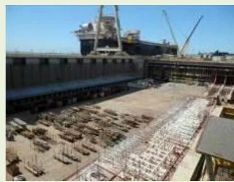
Vista do Dique Seco
