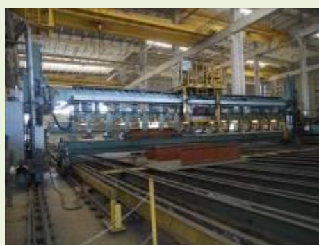
LINHA FABRICAÇÃO PAINÉIS MARCA OGDEN | Item: 316657 |
