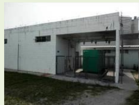
Vista da Subestação
