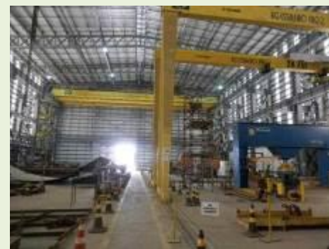
Vista Interna das Oficinas 2 e 3 e Fábrica de Blocos Curvos
