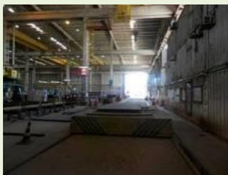
Vista Interna do Galpão das Oficinas
