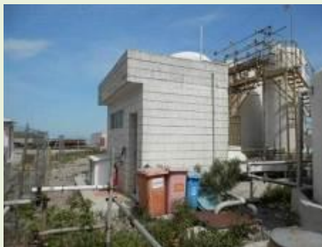
Vista da ETE 2
