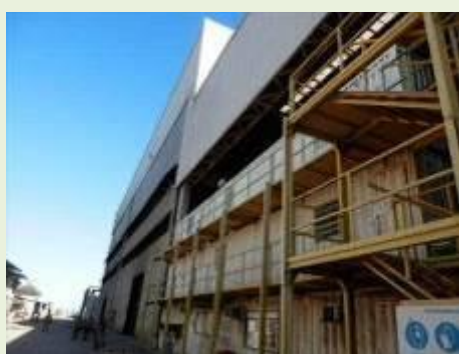
Vista do Galpão das Oficinas
