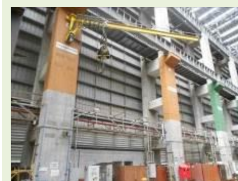
BRAÇO GIRATORIO (SWIVEL SERVICE BEAM) ELETRICO 180 GRAUS, COMPRIMENTO 5M MARCA IMG SERIE K7540.52SSB1.1 | Item: 100200 |
