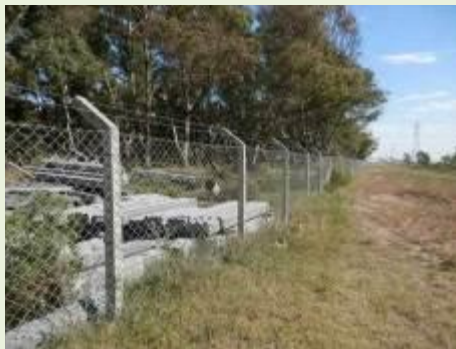
Vista da Frente da ERG 3
