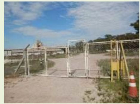
Vista da Frente da ERG 3 - Portão de Acesso ao Terreno
