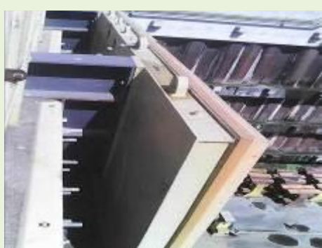
DEFENSER DE PLACA METALICA C/ BAQUELITE E BORRACHA DO DIQUE DIM 6,10X6,10 M | Item: 200085 |
