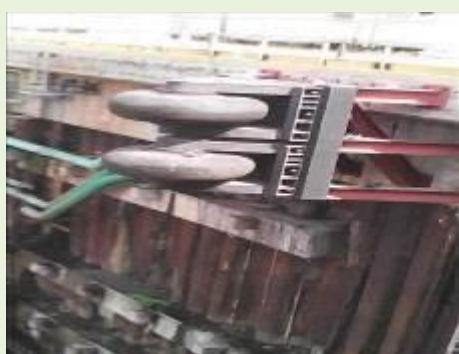
ROLLER FENDER / 2 ROLLER MARCA IRMOME MOD DR-175-60 | Item: 200092 |
