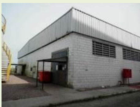
Vista do Almoxarifado de Tintas
