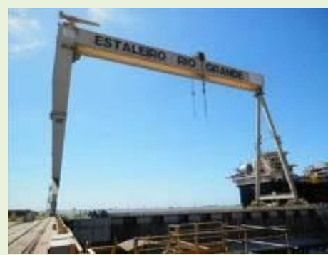
Vista do Dique Seco e Pórtico 2000t
