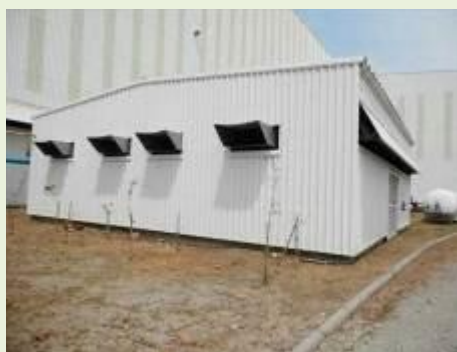
Vista da Central de Compressores
