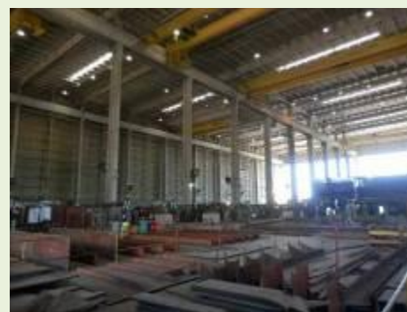
Vista Interna do Galpão das Oficinas
