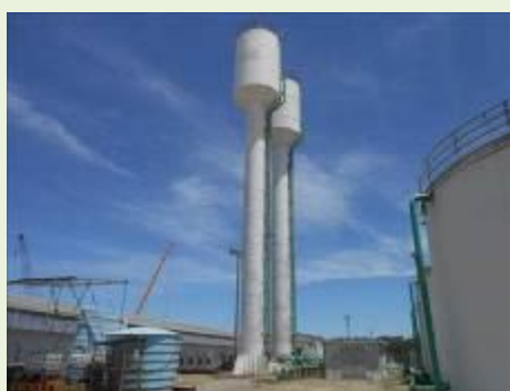
RESERVATORIO TIPO TAÇA MARCA AGROMETAL CAP. 85 M 3 DIAM.TAÇA 4,77M ALTURA TAÇA 6.90M ALTURA TOTAL 33,10M PESO 36.600KG | Item: 510257 |
