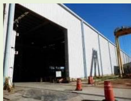
Vista do Galpão das Oficinas
