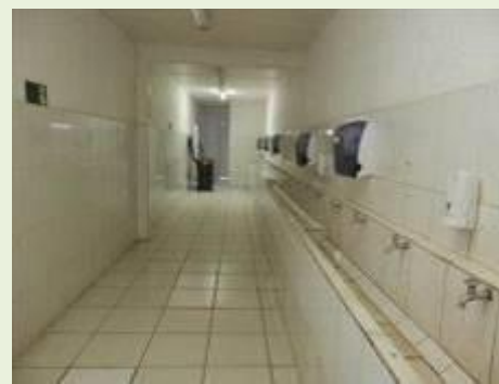
Vista Interna do Vestiário 2
