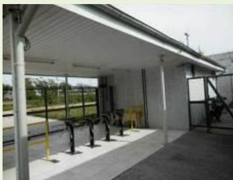
Vista da Portaria de Pedestres
