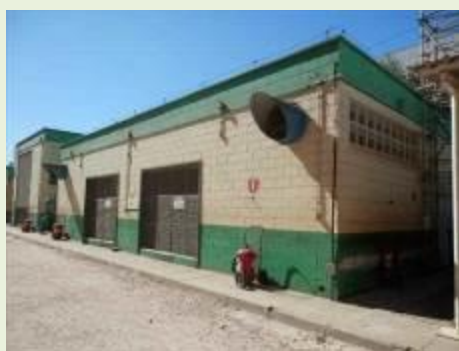
Vista da Subestação C1
