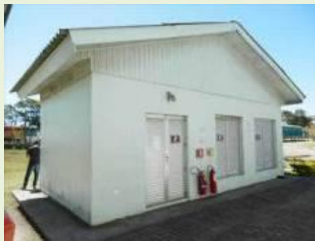
Vista da Subestação 1
