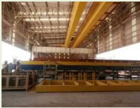
Vista Interna do Oxycorte
