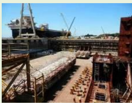
Vista do Dique Seco
