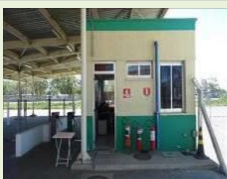
Vista da Portaria de Pedestres
