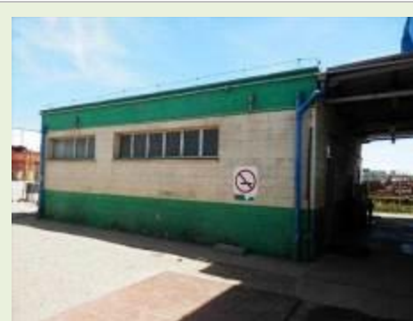
Vista dos Sanitários C3
