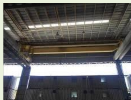
PONTE ROLANTE BIVIGA MARCA BREVIL NR.369/06 CAP.16 TON VÃO 18X8M ALTURA COM COMANDO CABINE (PR-03) | Item: 510116 |
