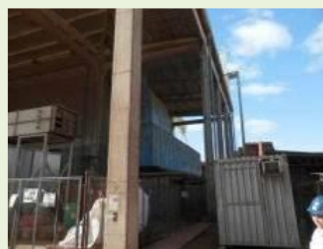
Vista do Galpão de Pintura
