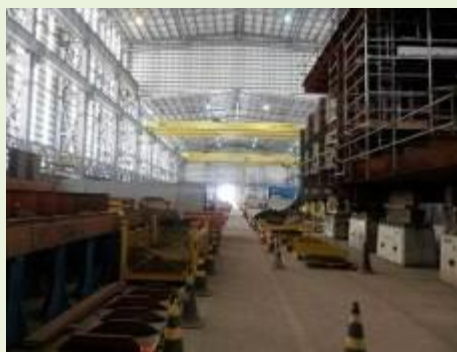
Vista Interna das Oficinas 2 e 3 e Fábrica de Blocos Curvos
