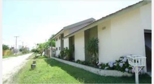
Vista da Rua Maria Araújo esquina c/ Rua Piratini
