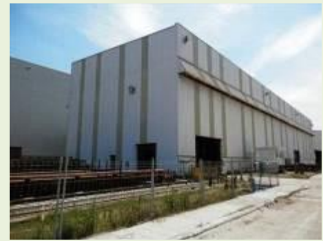
Vista do Galpão de Perfis
