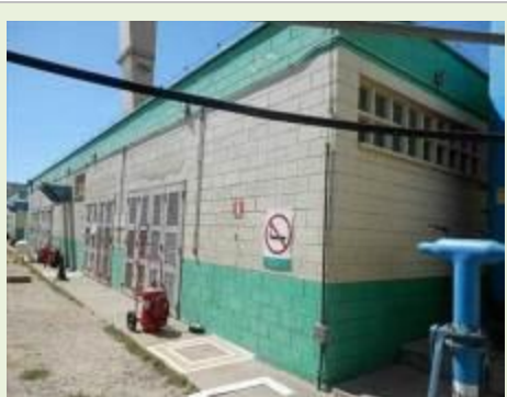
Vista da Subestação C3
