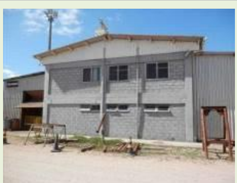
Vista da Oficina de Manutenção
