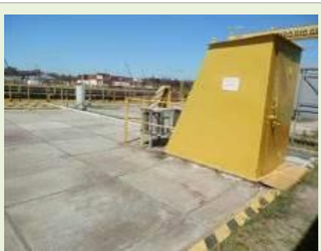
Vista da Laje de Cobertura e Acesso da Casa de Bombas do Dique
