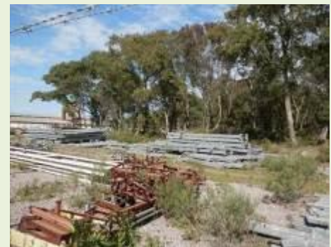
Vista da Frente da ERG 3
