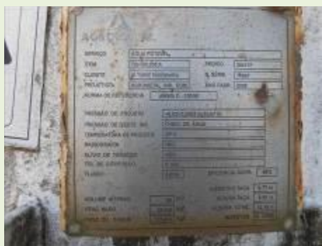
RESERVATORIO TIPO TAÇA MARCA AGROMETAL CAP. 85 M³ DIAM.TAÇA 4,77M ALTURA TAÇA 6.90M ALTURA TOTAL 33,10M PESO 36.600KG | Item: 510257 |
