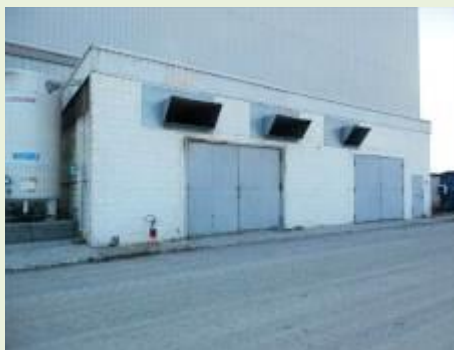
Vista da Central de Ar Comprimido
