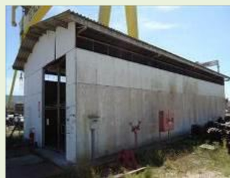
Vista do Almoxarifado de Tintas
