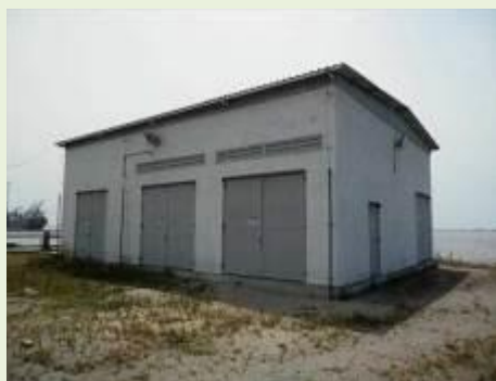
Vista da Subestação do Campo 1
