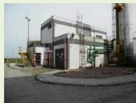
Vista da Casa de Bombas
