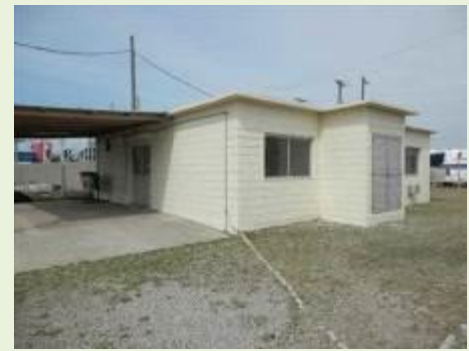
Vista do Ambulatório 2 Unimed
