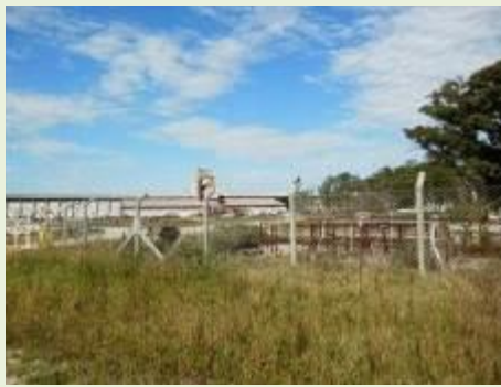
Vista da Frente da ERG 3
