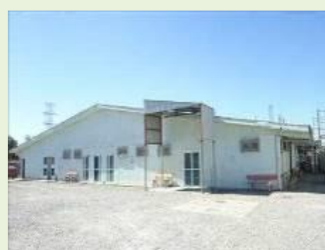
Vista do Refeitório
