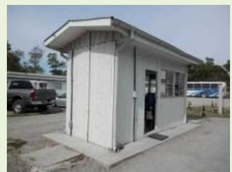
Vista da Guarita 1
