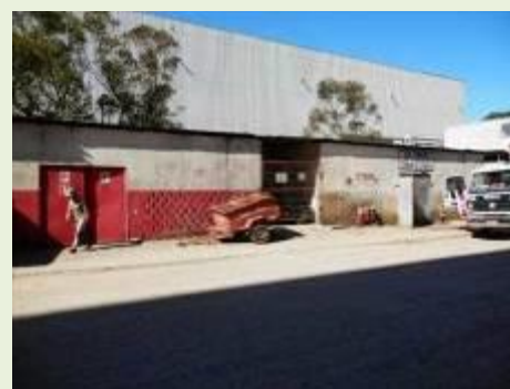
Vista da Central de Armazenamento Meio Ambiente
