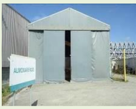
Vista de Almoarifado de Lona
