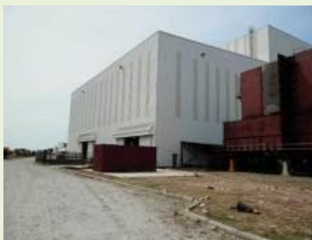
Vista das Oficinas 2 e 3 e Fábrica de Blocos Curvos
