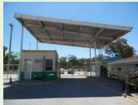
Vista da Portaria 02 Credenciamento
