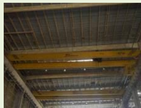
PONTE ROLANTE BIVIGA MARCA BREVIL NR.419/07 CAP.40 TON VÃO 30X25M ALTURA COM COMANDO CABINE (PR-13) | Item: 510100 |
