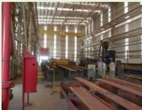
Vista Interna do Galpão de Perfis
