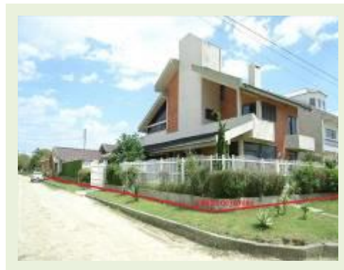
Vista da esquina da Rua Piratini c/ Av. Beira Mar
