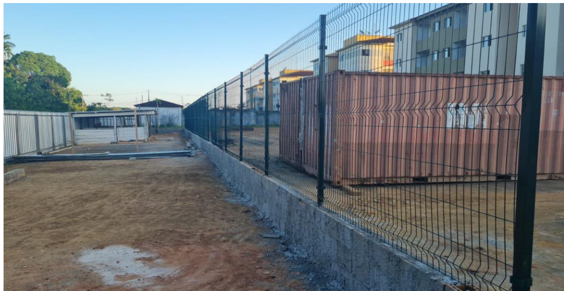
BELA VISTA - SUBCOND. ALFAZEMA (Em andamento)
