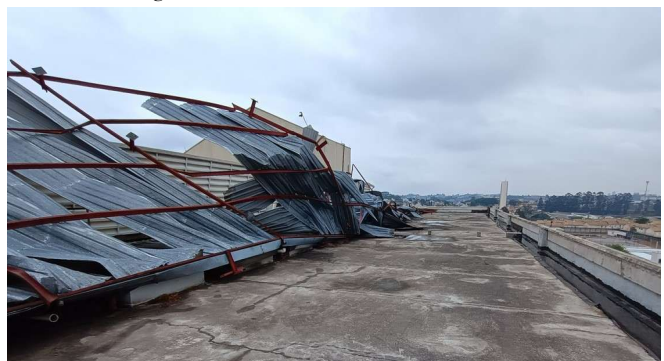
Imagem 04 – Telhado danificado
