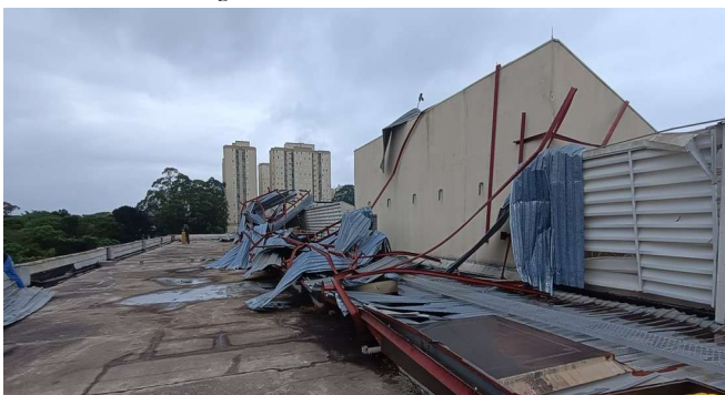
Imagem 03 – Telhado danificado
