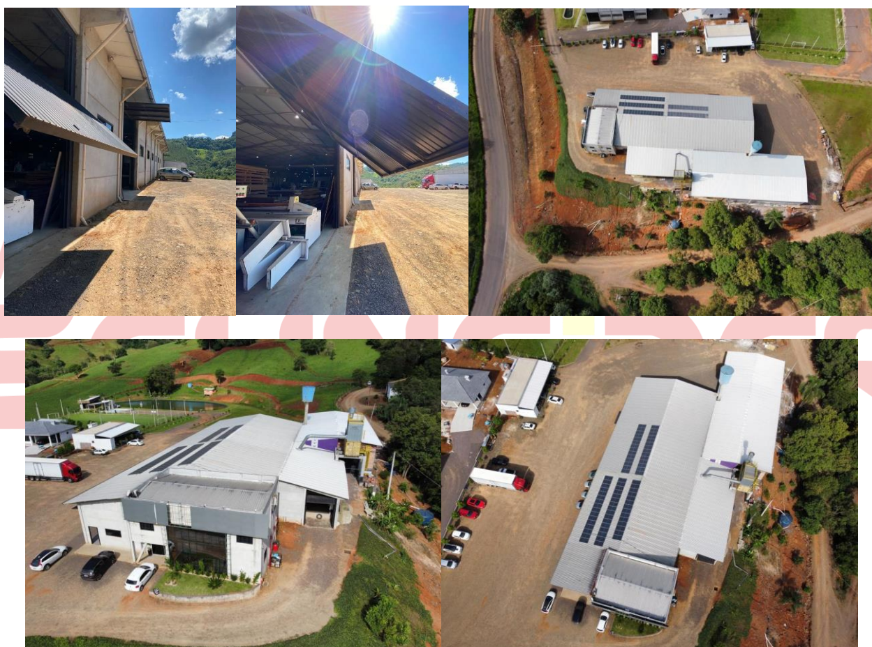
Barracão em pré-moldado e em estrutura metálica. Imagens feitas na data de 25/10/2023.
