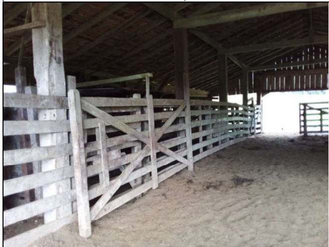
INTERIOR GALPÃO 1 – 270,00M 2
