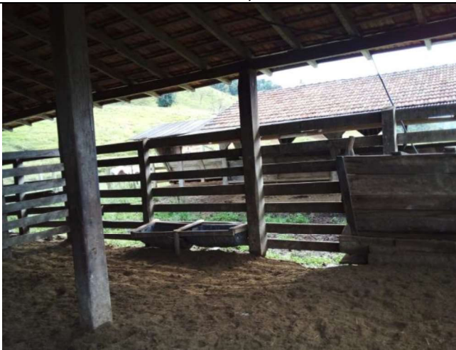
INTERIOR GALPÃO 1 – 270,00M 2
