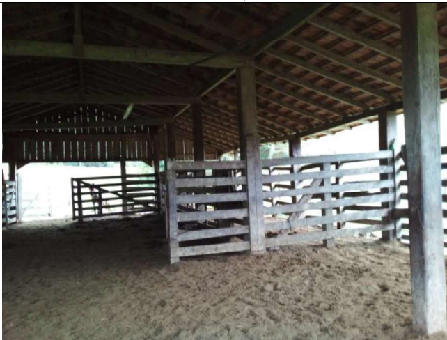
INTERIOR GALPÃO 1 – 270,00M 2
