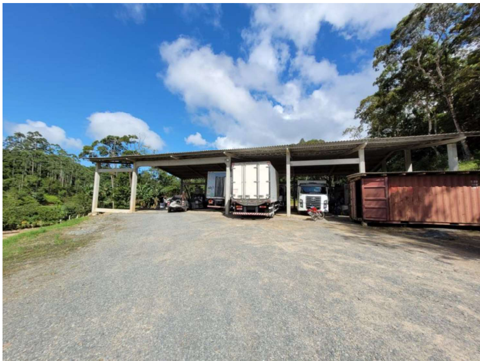
Estrutura Pré-Moldada da Oficina
