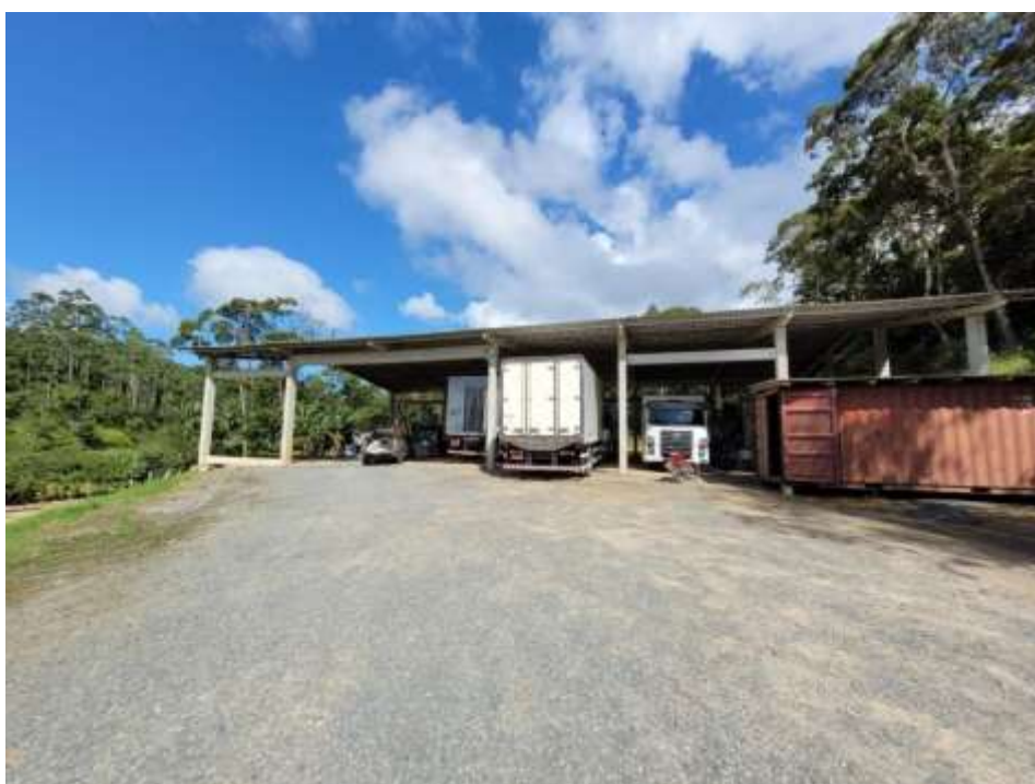
Estrutura Pré-Moldada da Oficina
