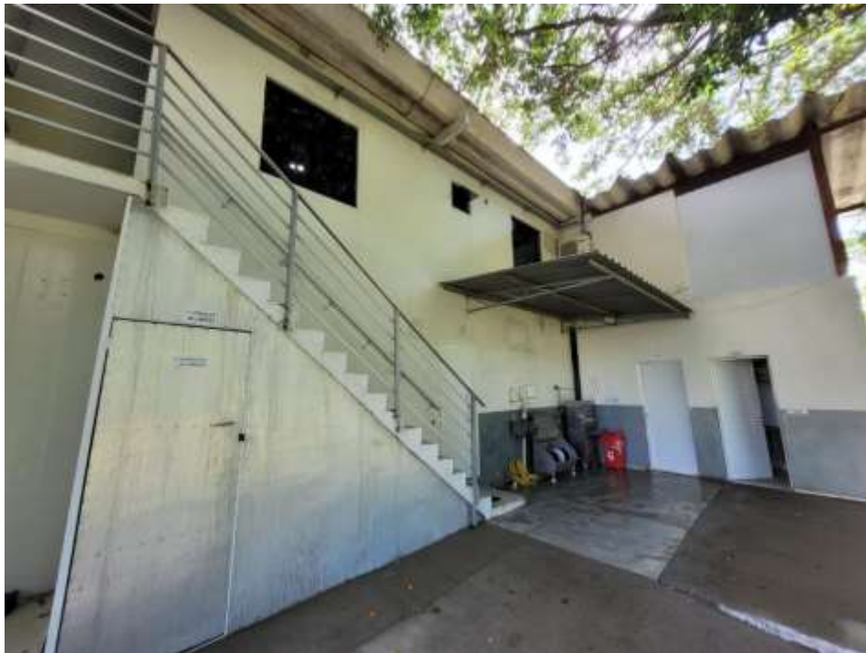
Acesso ao Administrativo
