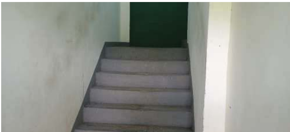
Foto 04 – Detalhe da escadaria que dá acesso aos andares superiores.
