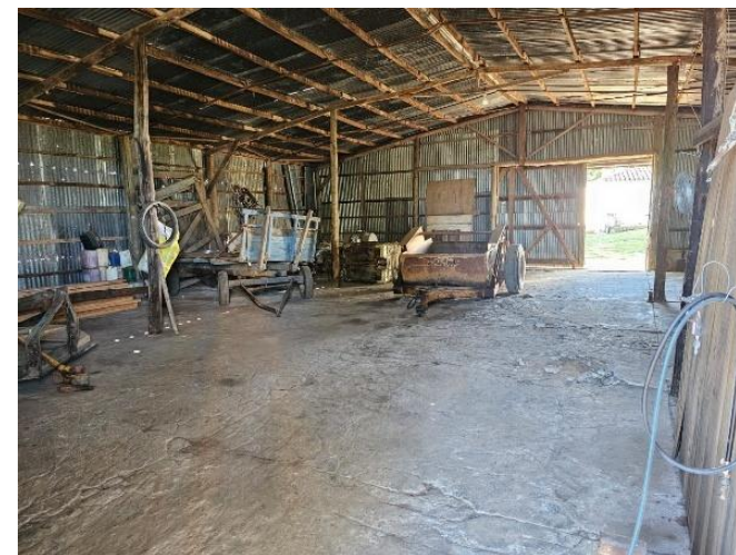
Estruturas: Cercas e divisões de piquetes em bom estado de conservação.
