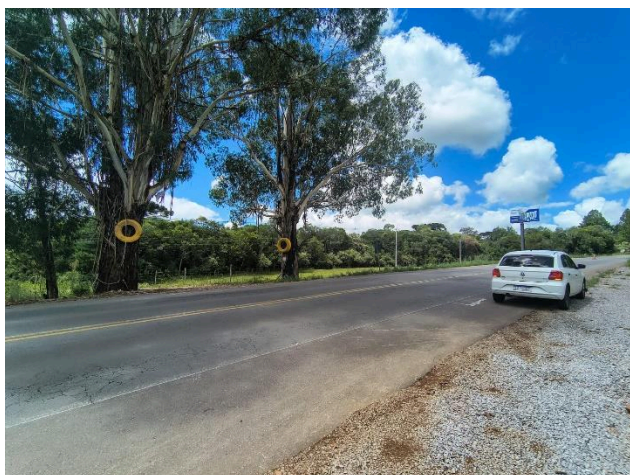
Vista da área a partir da Rodovia RS-453 – Rota do Sol – Vila Seca, Caxias do Sul -RS.
