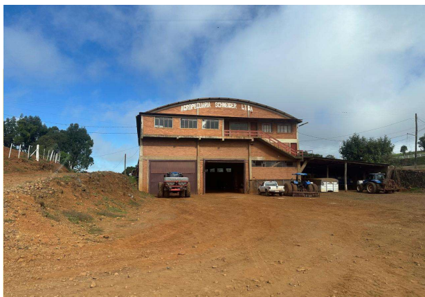
Infraestrutura: galpão principal para abrigo de máquinas e implementos agrícolas.
