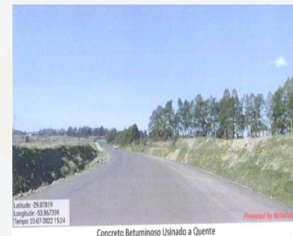
Concreto Betuminoso Usinado a Quente
