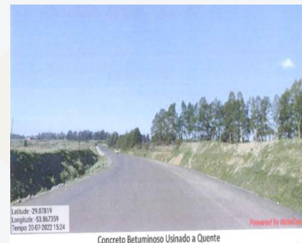
Concreto Betuminoso Usinado a Quente
