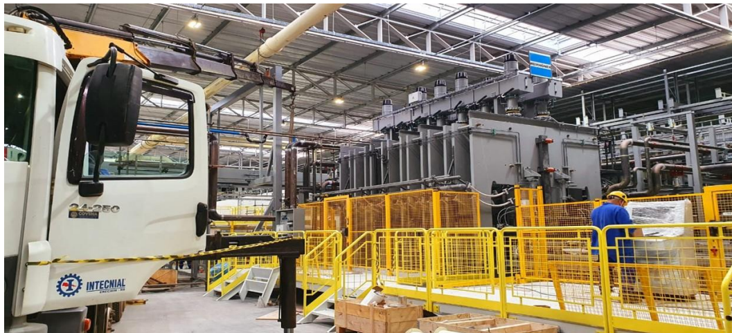
Montagem eletromecânica da linha BP - Berneck
