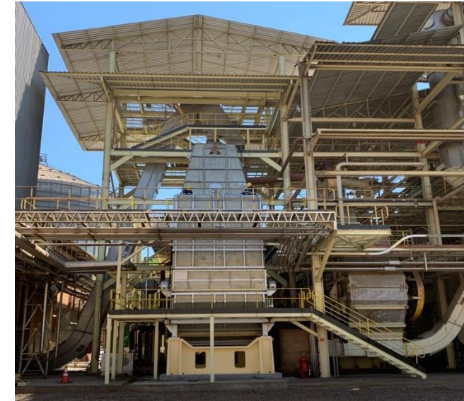
Instalação do novo extrator myande - Olfar
