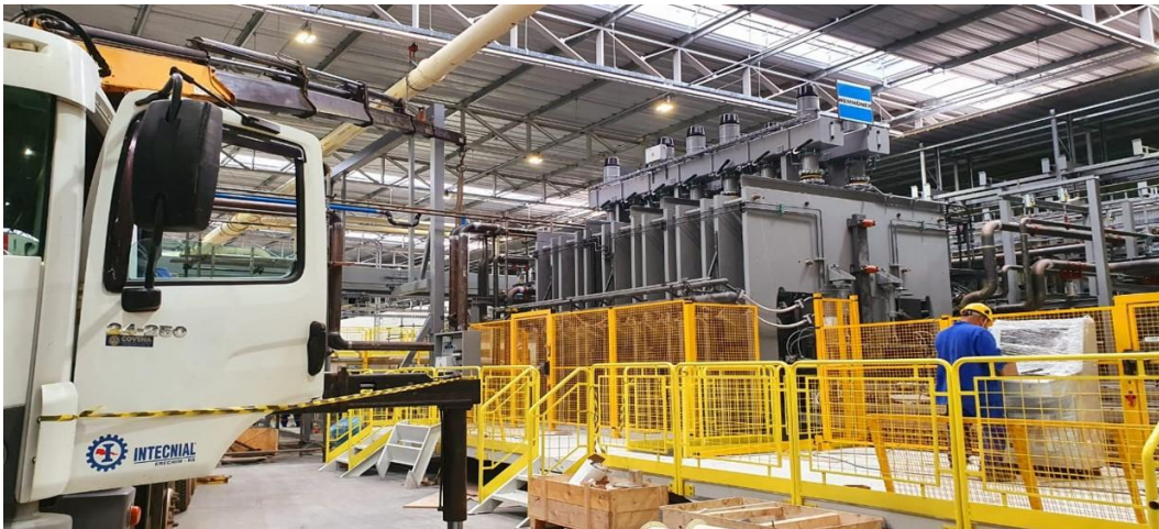
Montagem eletromecânica da linha BP - Berneck
