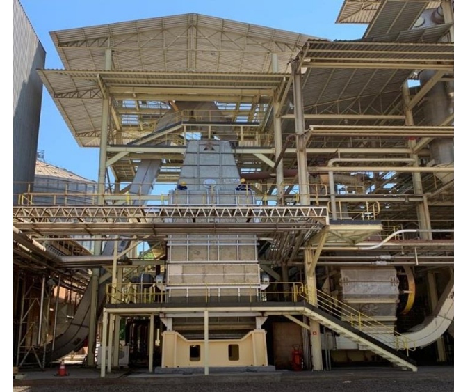
Instalação do novo extrator myande - Olfar
