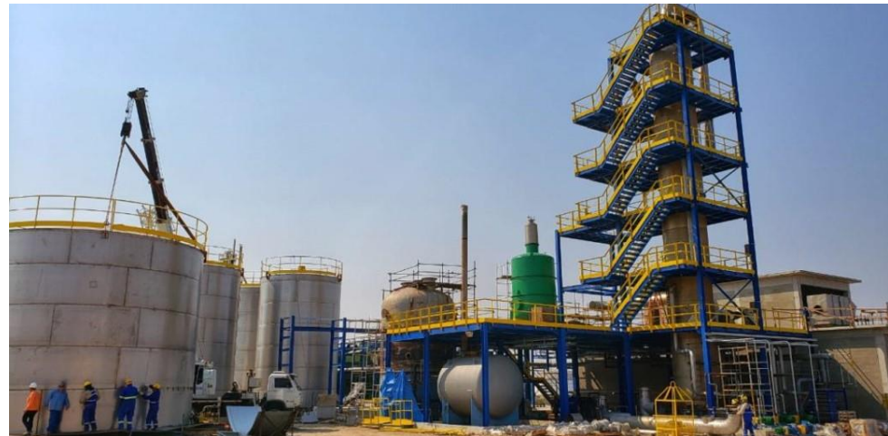
Montagem eletromecânica da linha de formol – GPC Química
