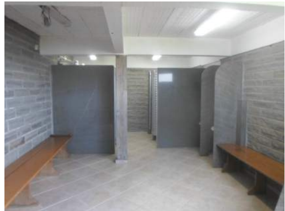
Foto 20: Vestiário masculino – quiosque
