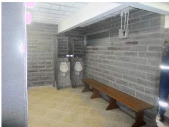
Foto 21: Vestiário masculino – quiosque
