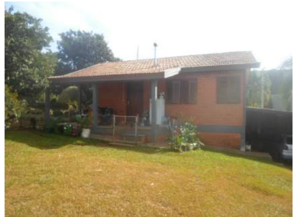
Foto 08: Residência do caseiro – Fachada
