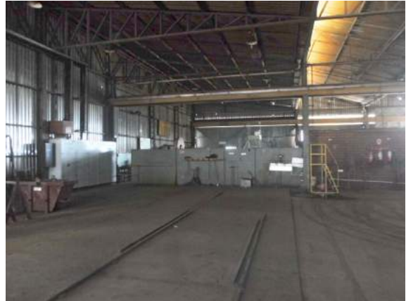
Foto 32: Benf 01 – Corte de chapas - interna
