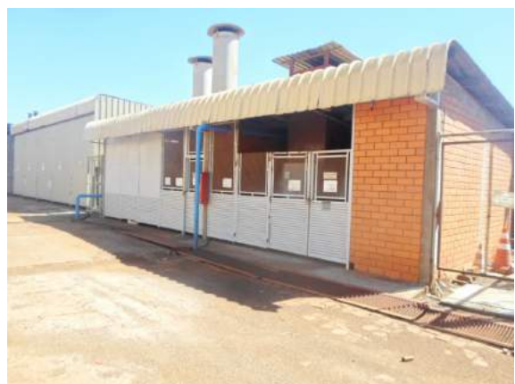
Foto 60: Benf 30/31, Abrigo Gerador/Comp
