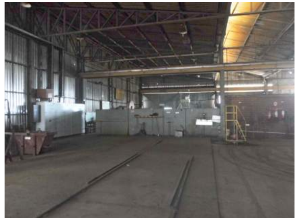
Foto 28: Benfeitoria 12 – Vista interna
