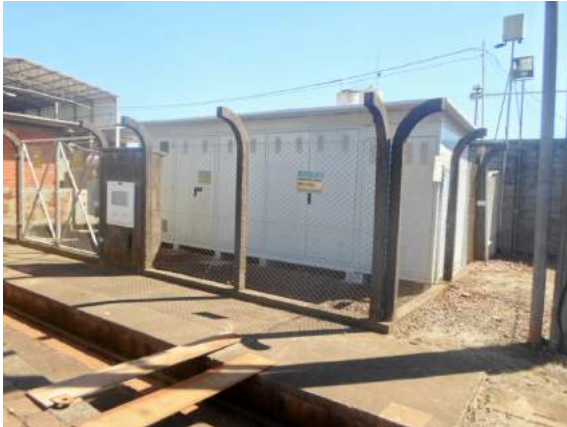
Foto 55: Benfeitoria 13, Abrigo Subestação
