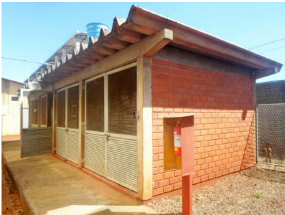
Foto 57: Benfeitoria 03, Abrigo Compressor
