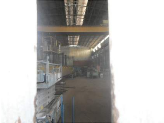
Foto 43: Benf 05, Caldeiraria, Vista interna
