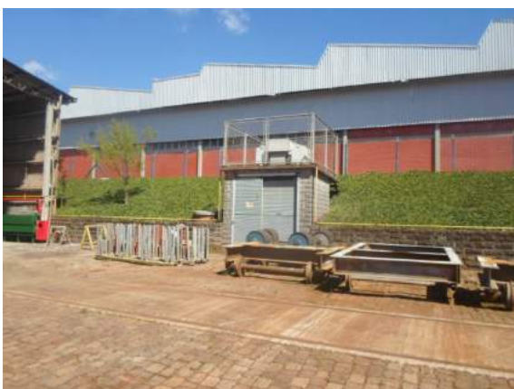
Foto 65: Benfeitoria 40, Abrigo Subestação
