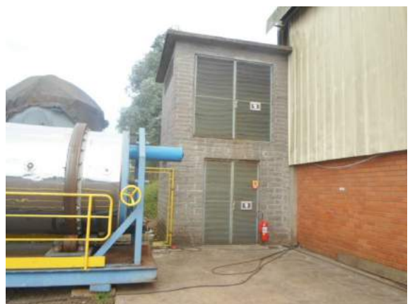
Foto 66: Benfeitoria 39, Abrigo Subestação
