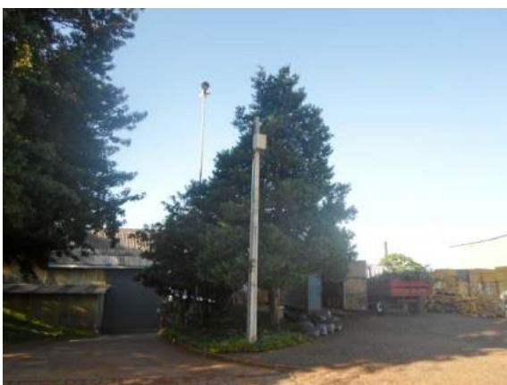
Foto 53: Sistema de Monitoramento/Alarme
