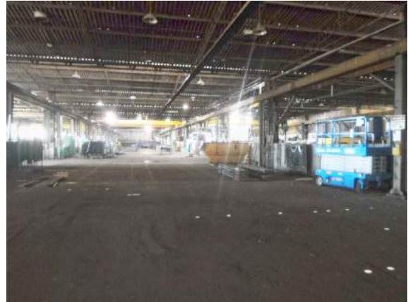
Foto 26: Benfeitoria 12 – Vista interna
