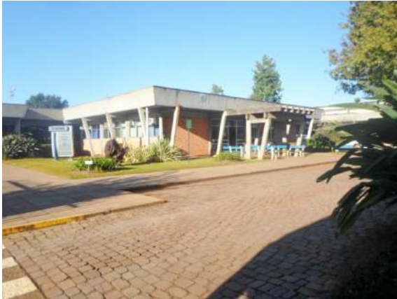
F13: Benf 14 Fachada Prédio Área Técnica
