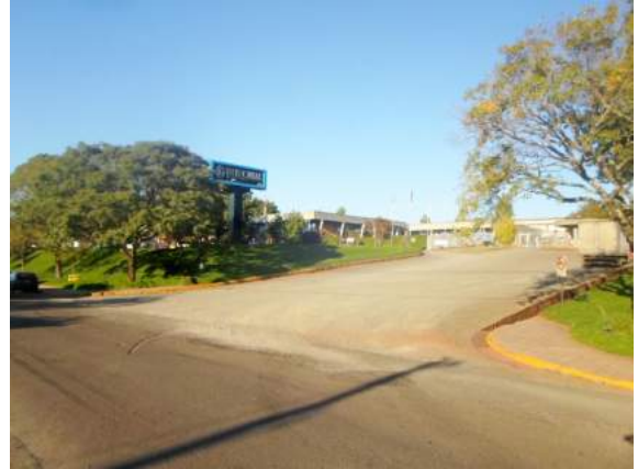
F02: Entrada de acesso à empresa
