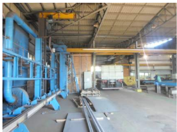
Foto 24: Benfeitoria 22 – Vista interna
