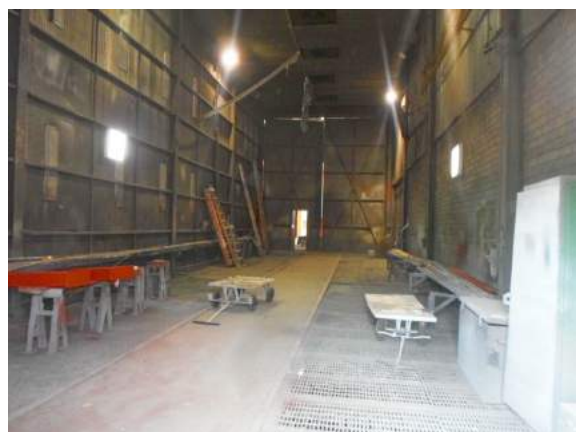
Foto 42: Benf 05, Caldeiraria, Vista interna
