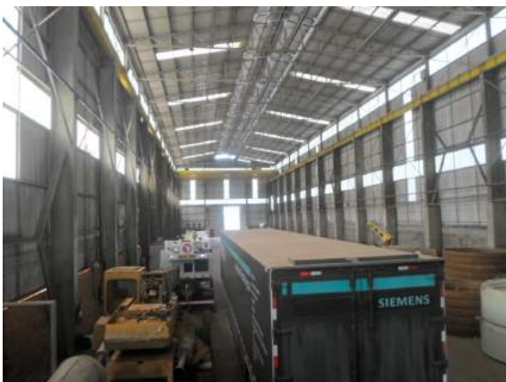
Foto 47: Benf 34, Pav Inox, Vista interna
