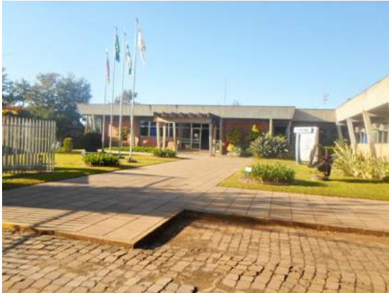
F07: Benfeitoria - 15 Prédio administrativo
