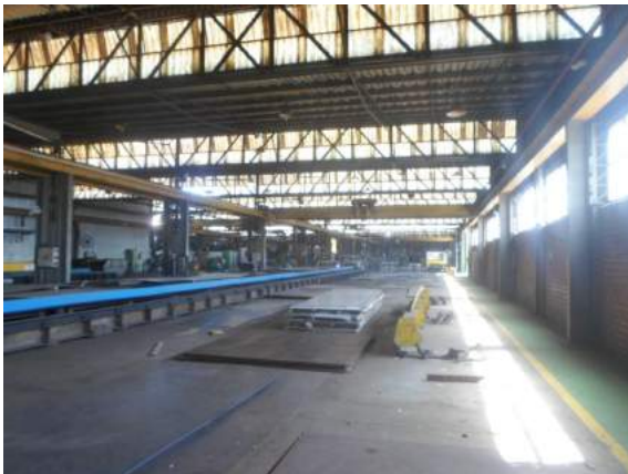
Foto 27: Benfeitoria 12 – Vista interna
