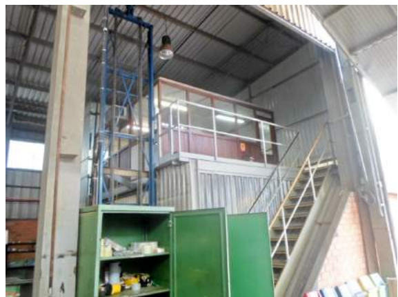
Foto 48: Benf 34, Pav Inox, Vista interna
