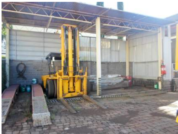
Foto 69: Benfeitoria 24, Abrigo de Diesel
