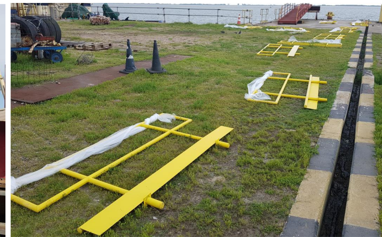
Manutenção guarda-corpo dique
