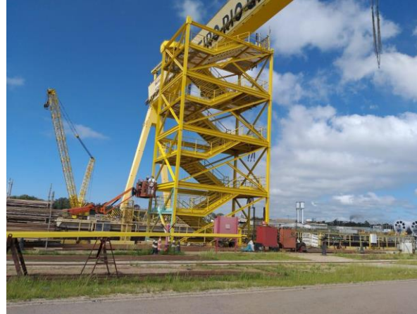
Manutenção Escadas de Acesso
