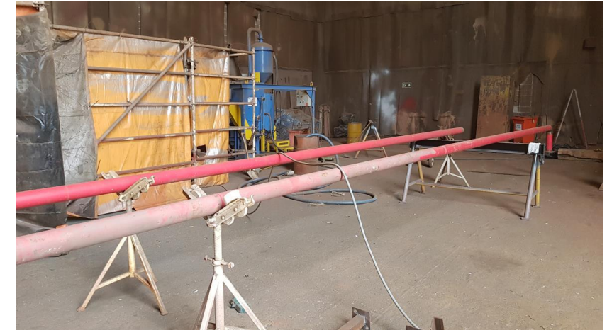
Execução de PPCI
