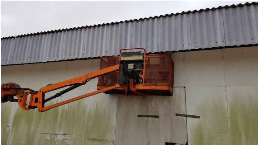
Instalação de proteções contra pombos
