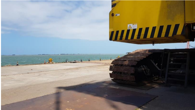
Manutenção Guindaste Sany 750 ton
