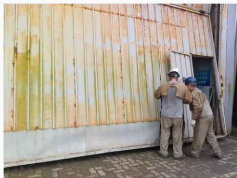
Manutenção Portão infraestrutura
