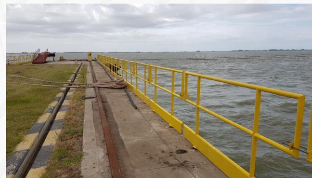
Manutenção Guarda Corpo
