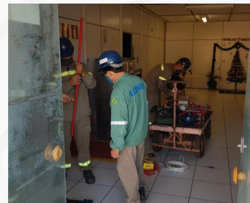
Execução de PPCI
