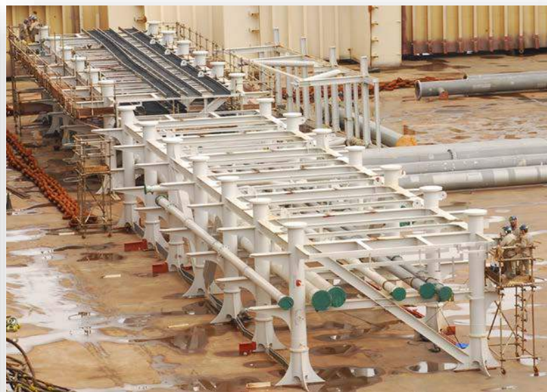
Estrutura metálica – Pipe rack de um FPSO
