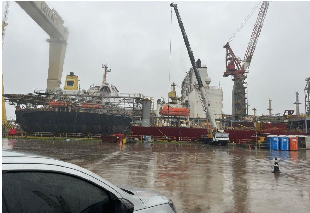
Plataforma P-32 para desmantelamento
