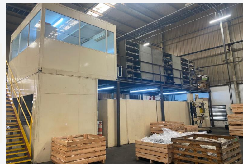
Manutenção de Máquinas
