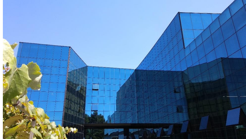
Vidroforte/RS – Fachada Interna.
