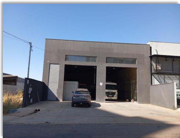
Templex GO – novo pavilhão
