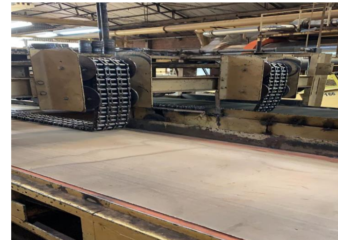
Substituição corrente mesa alimentação.
