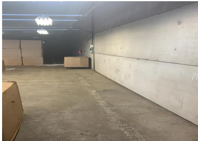
Paredes e nova iluminação.
