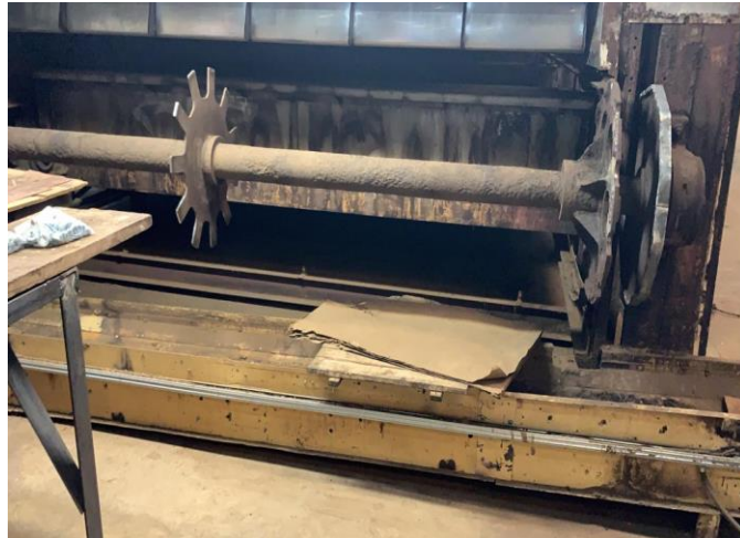
Esteira metálica secador.
