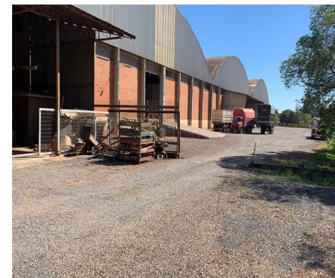
Fachada dos pavilhões da Sul América Tabacos. Fotos enviadas pela Recuperanda a esta Administração Judicial em 28/04/2021
