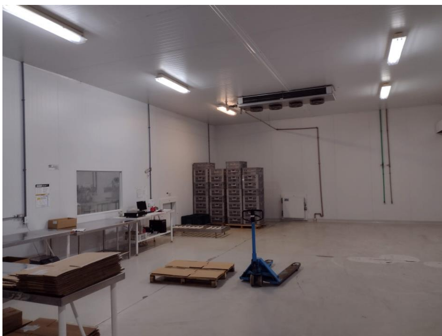
Foto superior: vista geral do imóvel
