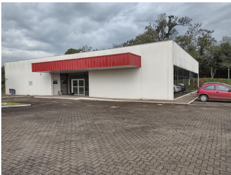
Foto superior: vista geral do imóvel
