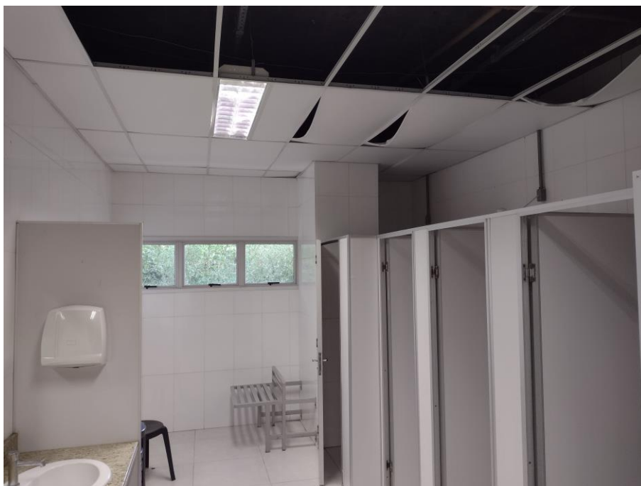
Foto superior: vista geral do imóvel
