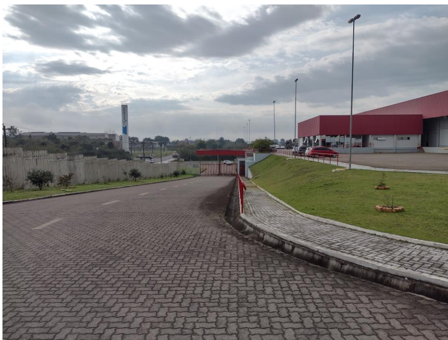
Foto superior: vista geral do imóvel
