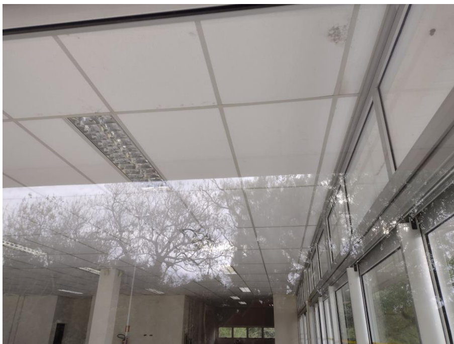
Foto superior: vista geral do imóvel
