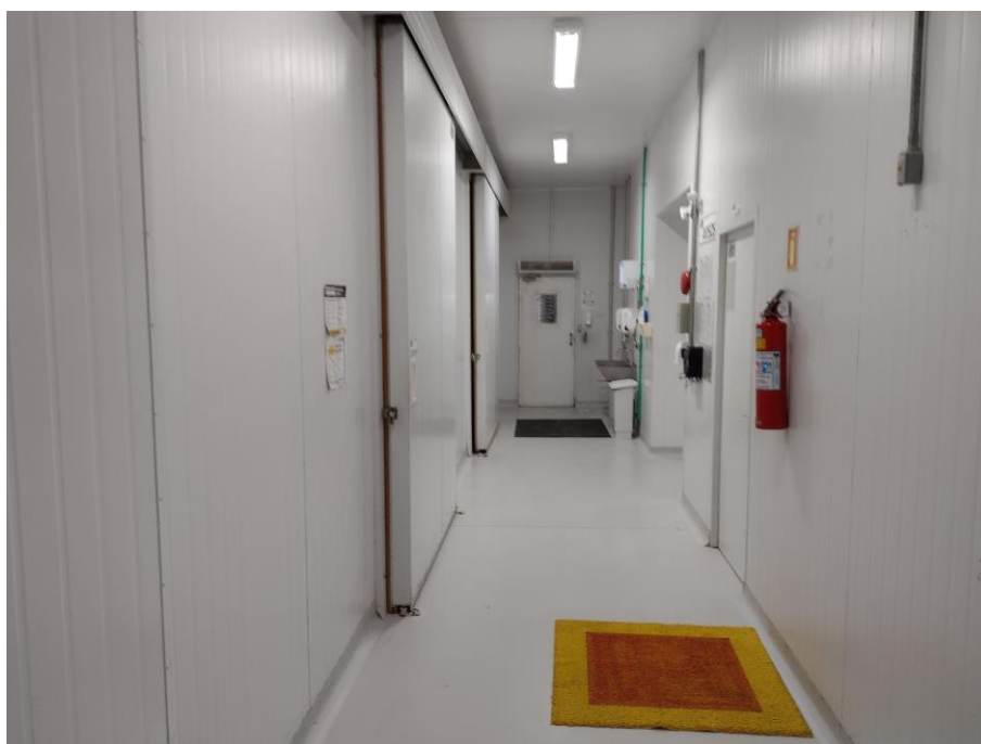
Foto superior: vista geral do imóvel
