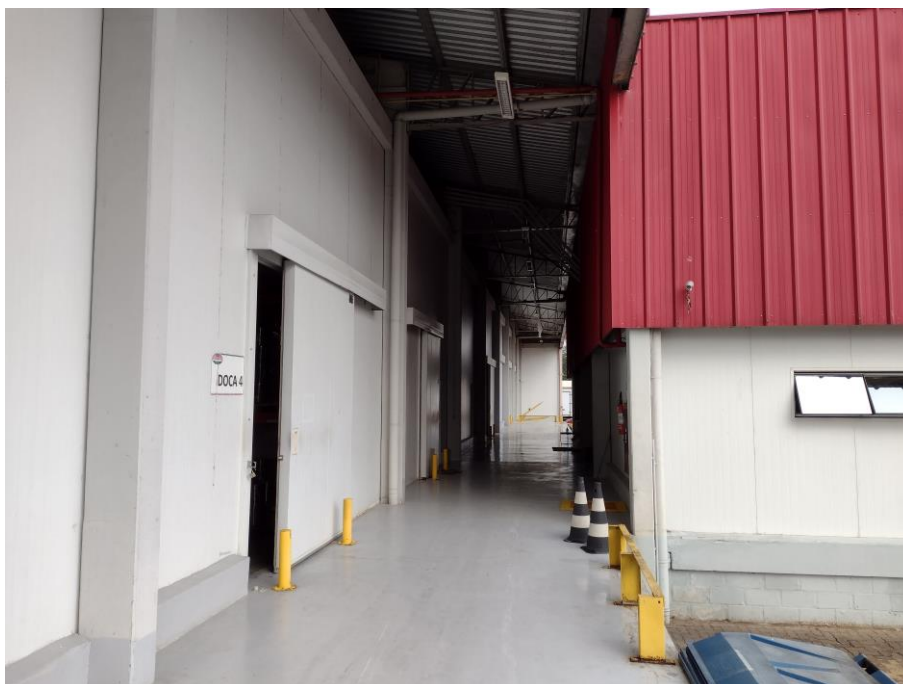
Foto superior: vista geral do imóvel
