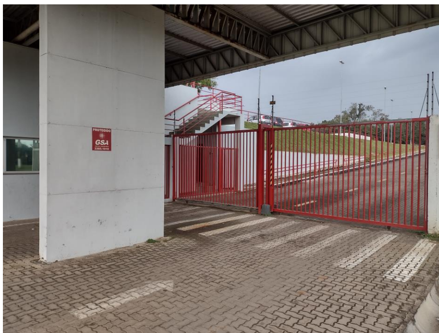
Foto superior: vista geral do imóvel
