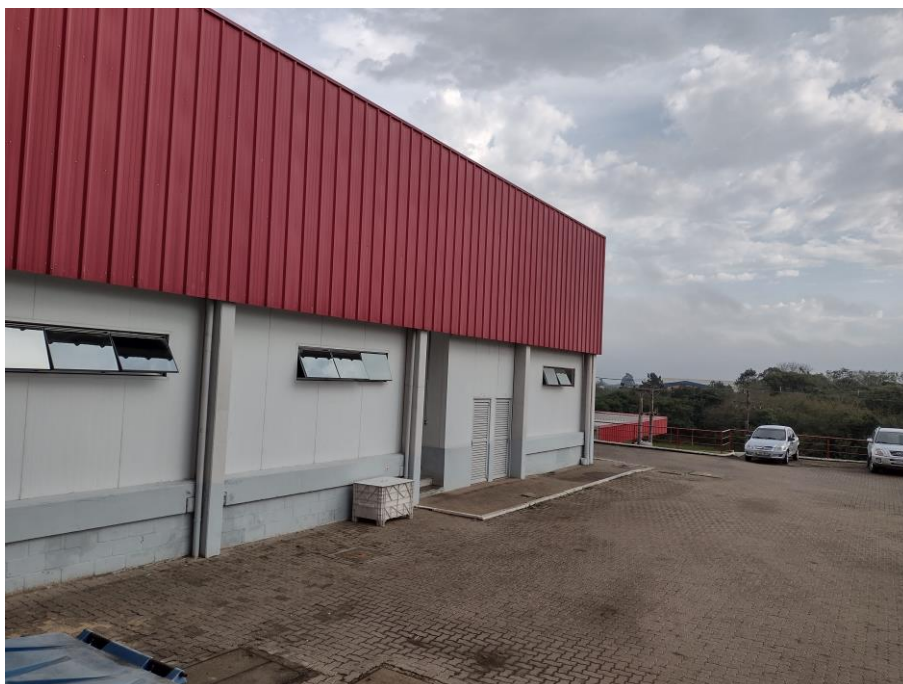
Foto superior: vista geral do imóvel
