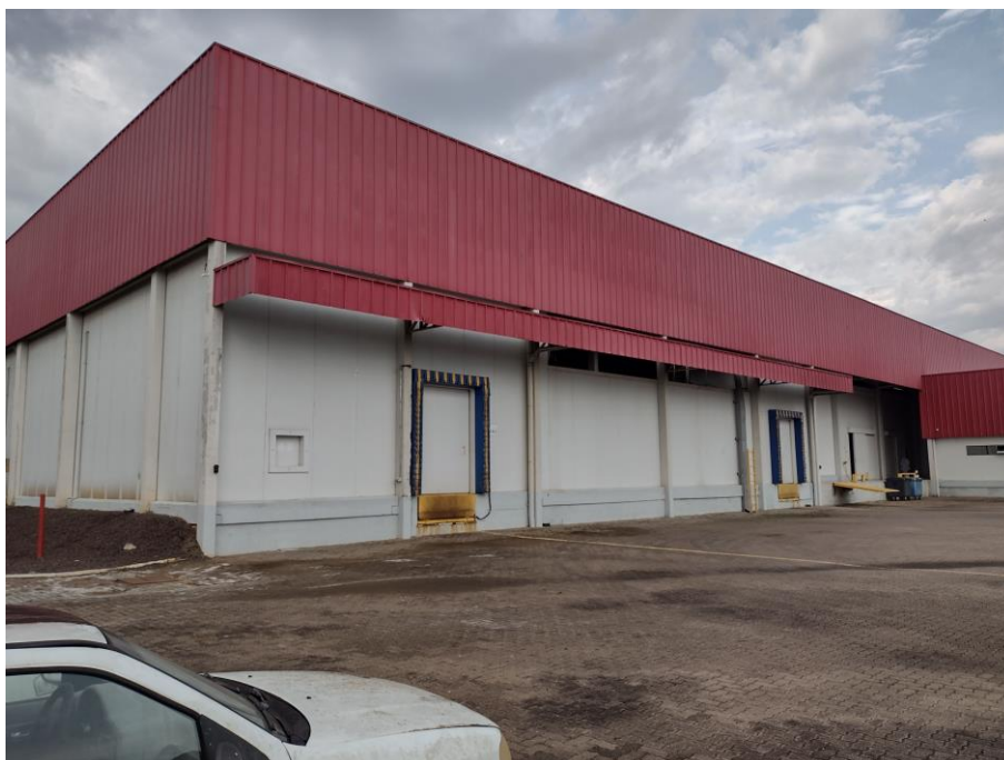
Foto superior: vista geral do imóvel
