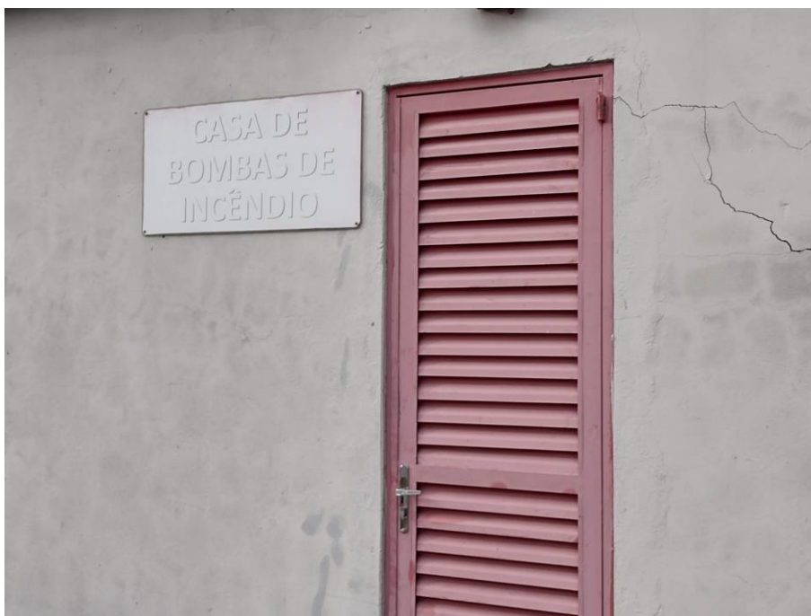
Foto superior: vista geral do imóvel
