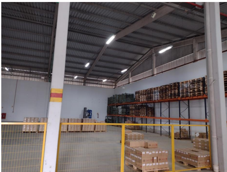
Foto superior: vista geral do imóvel
