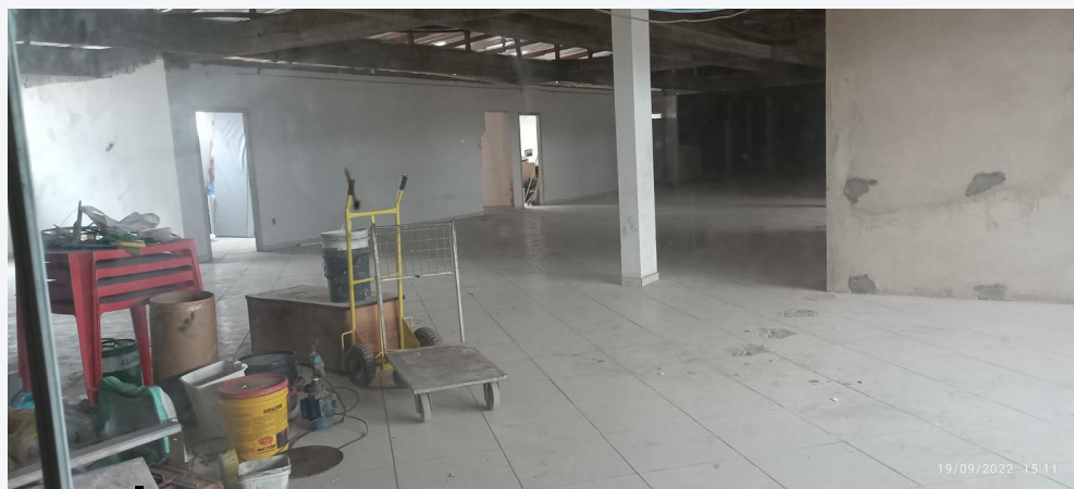
Área em construção para futura expansão da clínica
