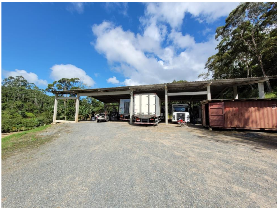
Estrutura Pré-Moldada da Oficina
