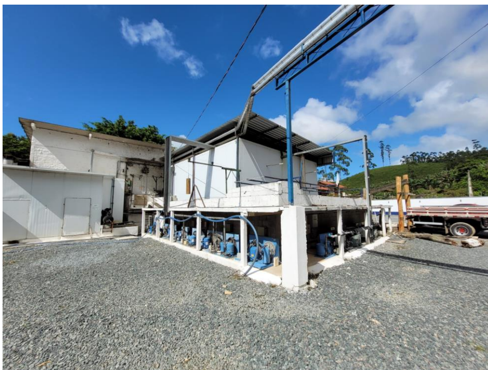
Galpão Principal Externo
