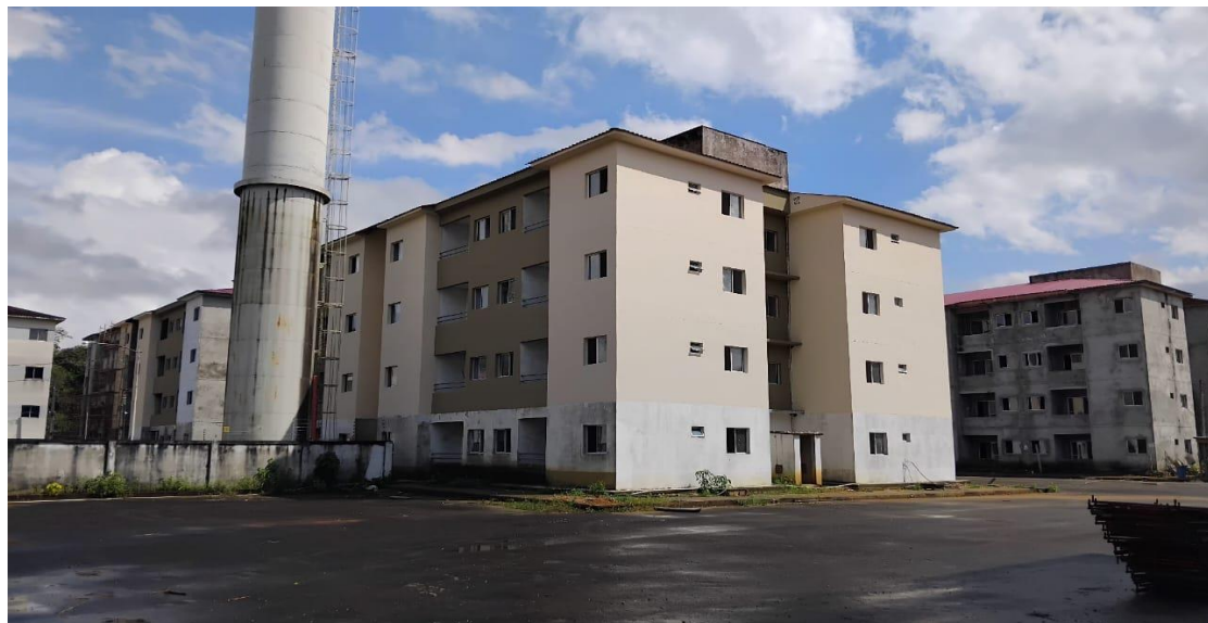
BELA VISTA - SUBCOND. ALFAZEMA (Em andamento)
