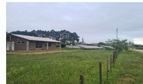
Equipamento de energia solar e alojamento dos caminhoneiros
