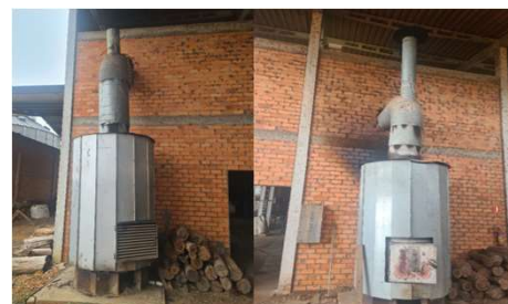
Caldeiras para regular umidade dos grãos colhidos
